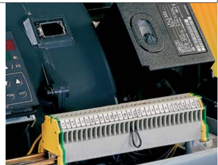
RLS/M MX型燃烧器 电气连接 线端子板示例
