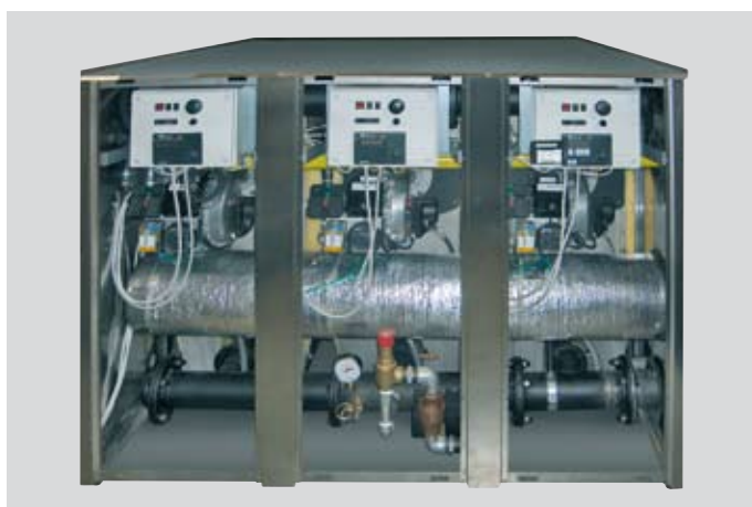
应用于模块式冷凝锅炉 (单位功率为150kW)
